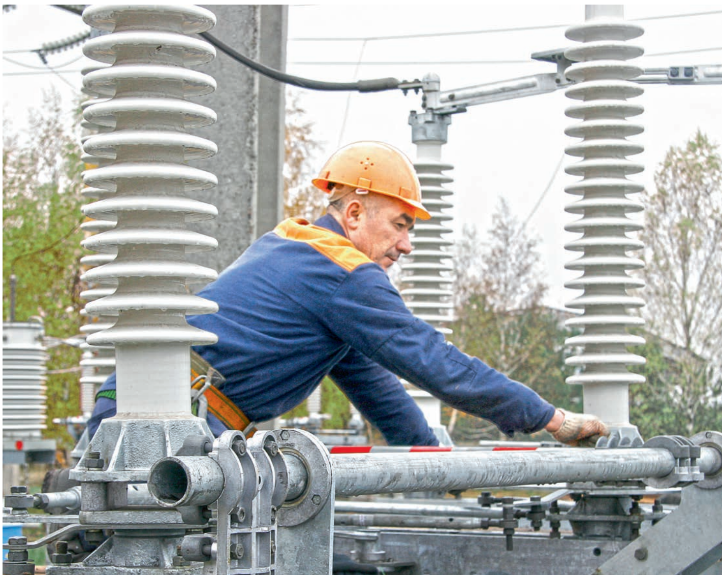
Цех включает в себя более 30 объектов, в его ведении находится более 500 километров кабельных и около 100 километров воздушных линий.
