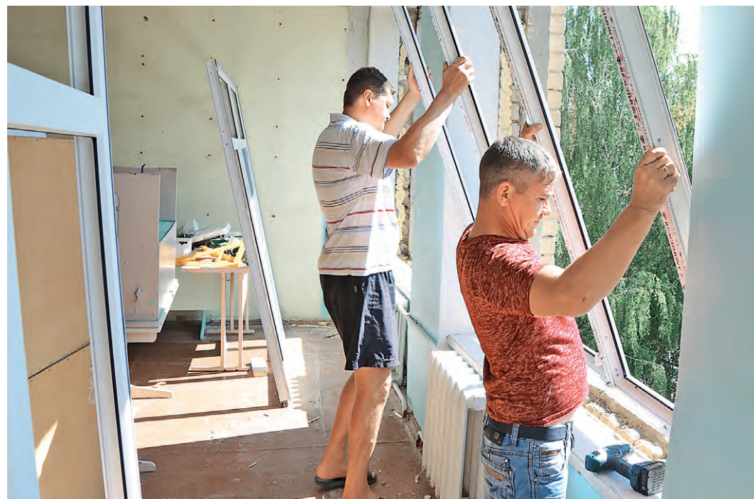
В лицее №3 заменили 28 окон.
