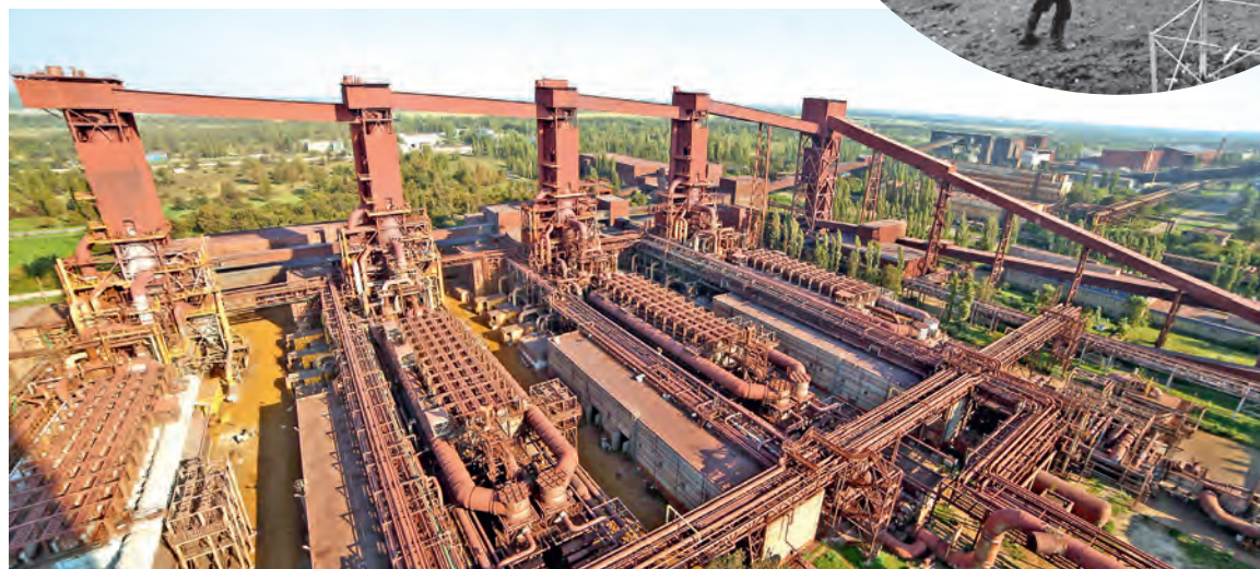
▲ Установки металлизации, 2024 год
