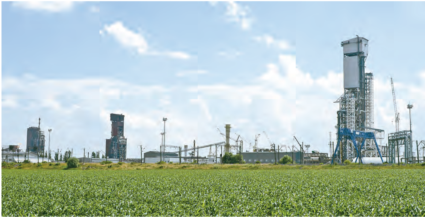
Строительство ЦГБЖ-3 приближается к финальной стадии.
