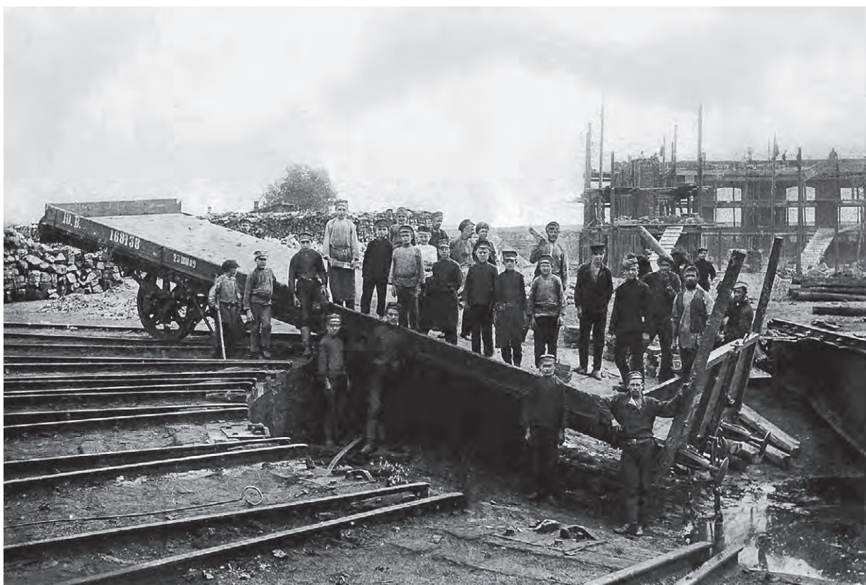
1930-е годы. Строительство поворотного стенда в локомотивном депо г. Старый Оскол.
