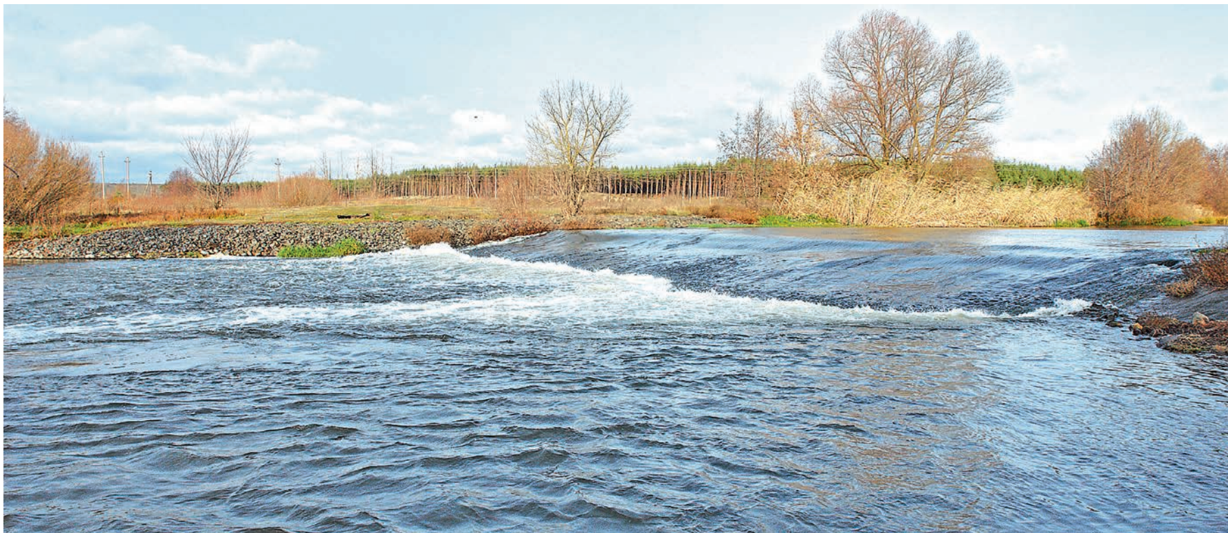
Русловая шпунтовая перемычка.
