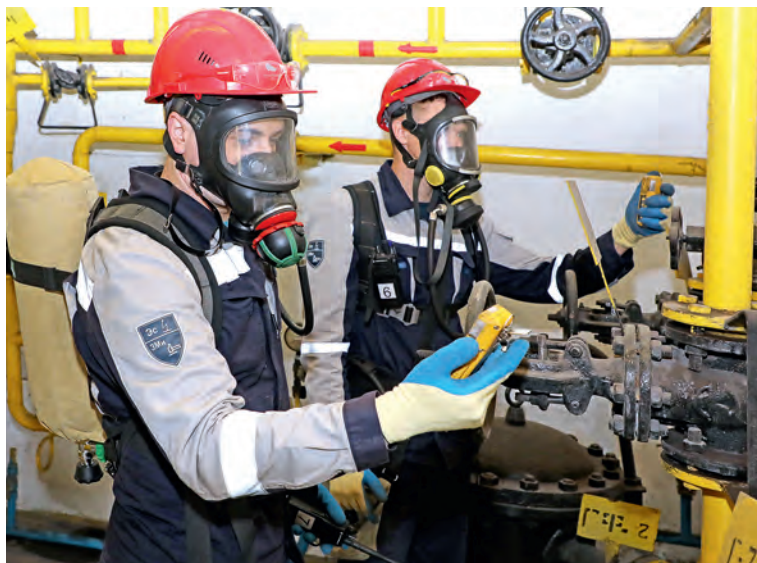
▲ Мониторинг загазованности газоопасного места при обходе
