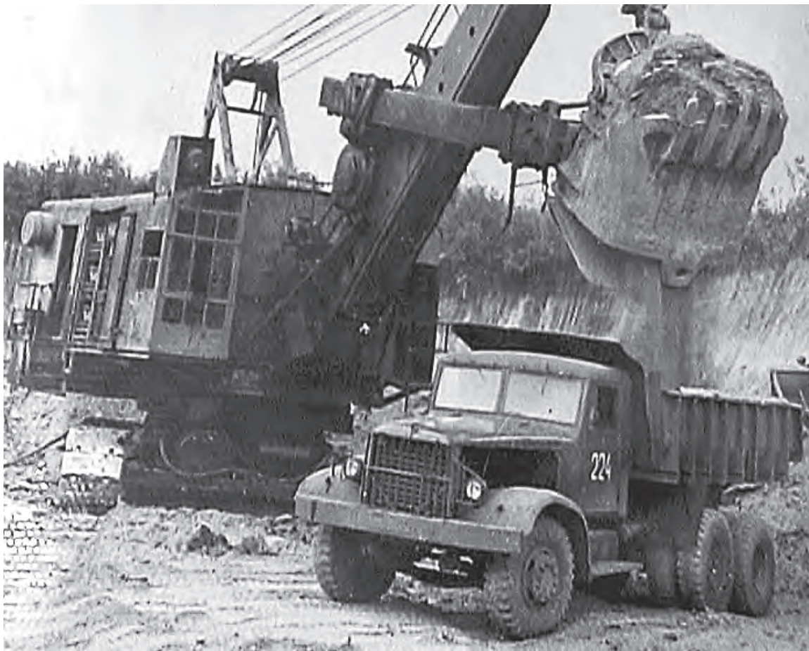
▲ Горные работы в карьере Михайловского ГОКа
