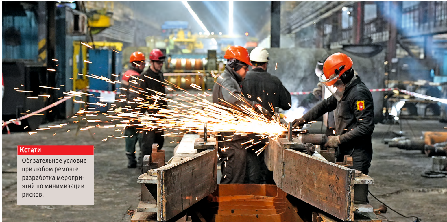
▲ Ремонт печи гомогенизации СПЦ № 1 длился 20 суток
