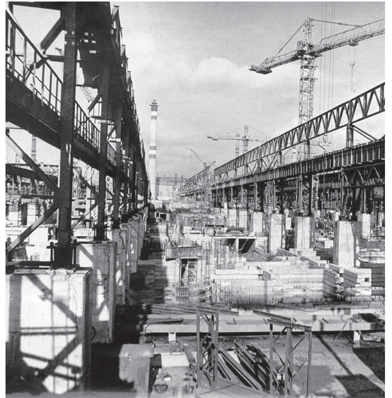
▲ ОЭМК – Всесоюзная ударная стройка
