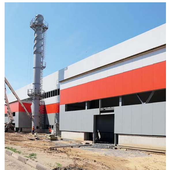
▲ Продолжается строительство термоотделения ЦОП
