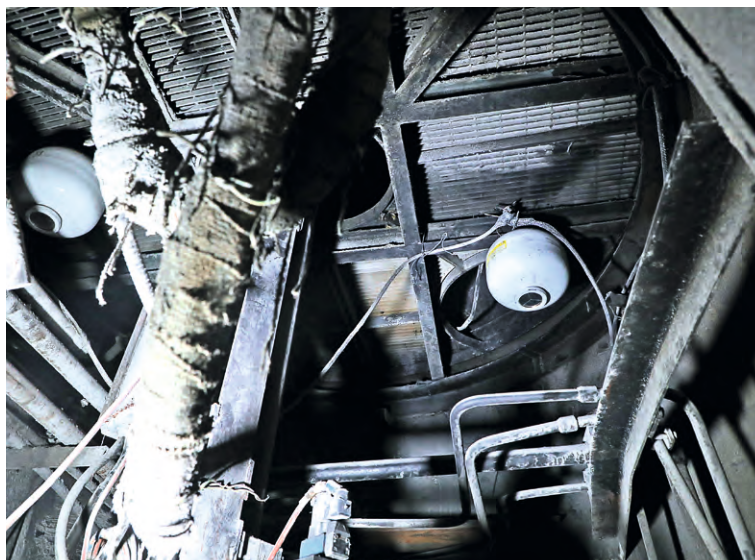
▲ Два модуля пожаротушения «Буран», оснащённые датчиком температуры, установили внутри колонны АКОС № 3
