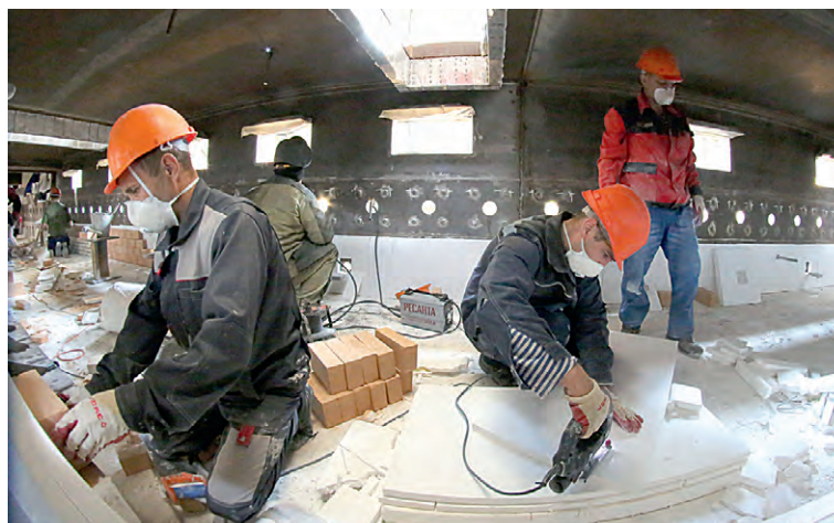
Параллельно ведётся их футеровка и оснащение
