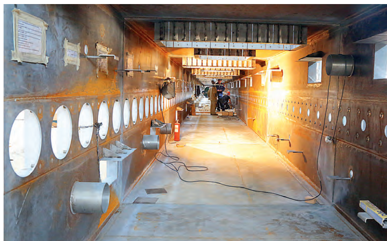
Монтаж секций корпусов двух печей
