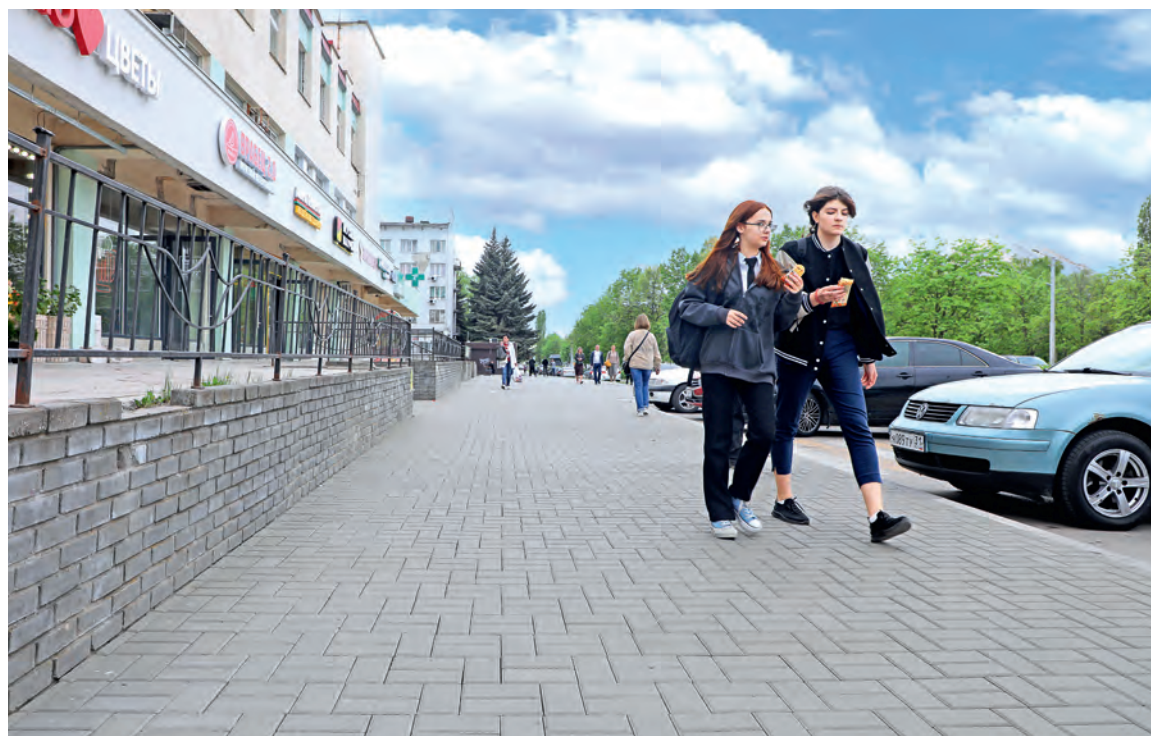
▲ Отремонтированный на средства Металлоинвеста тротуар в юго-западной части города
