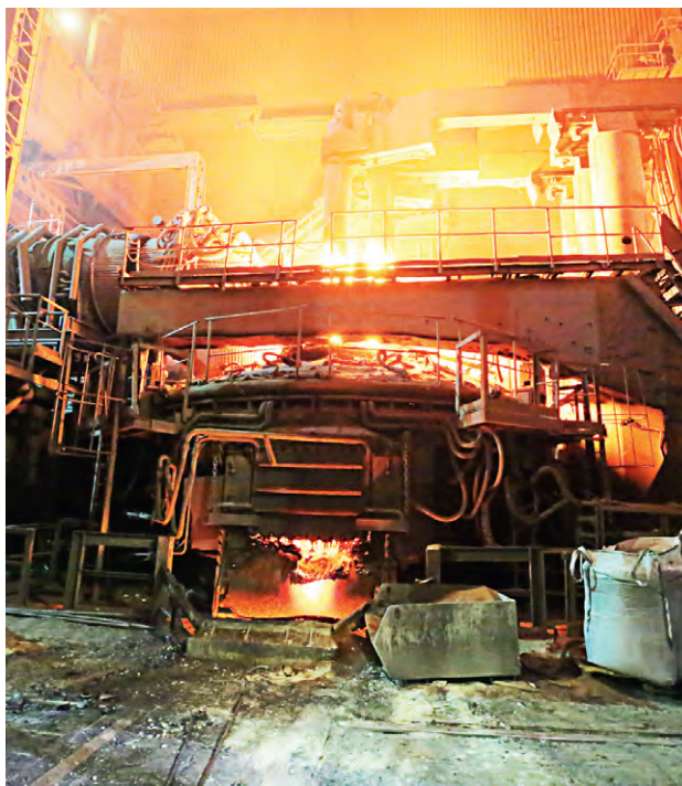
▲ Электродуговая сталеплавильная печь — большой и сложный агрегат
