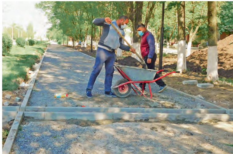
▼ В микрорайоне Молодогвардеец строители в первую очередь устраивают тротуары
