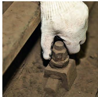
◀ Причина отказа от работы — на высоте 15 метров раскрутилась одна из гаек крепления рельса к подкладке
