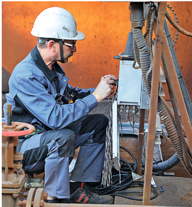
▲ Идёт ремонт оборудования установки металлзации
