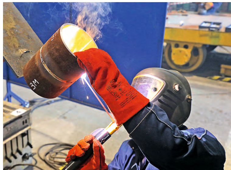
▲ Электрогазосварщики делают сварное соединение под сложным углом 45 градусов
