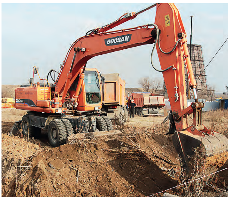
▲ На строительной площадке комплекса по производству продуктов разделения воздуха
