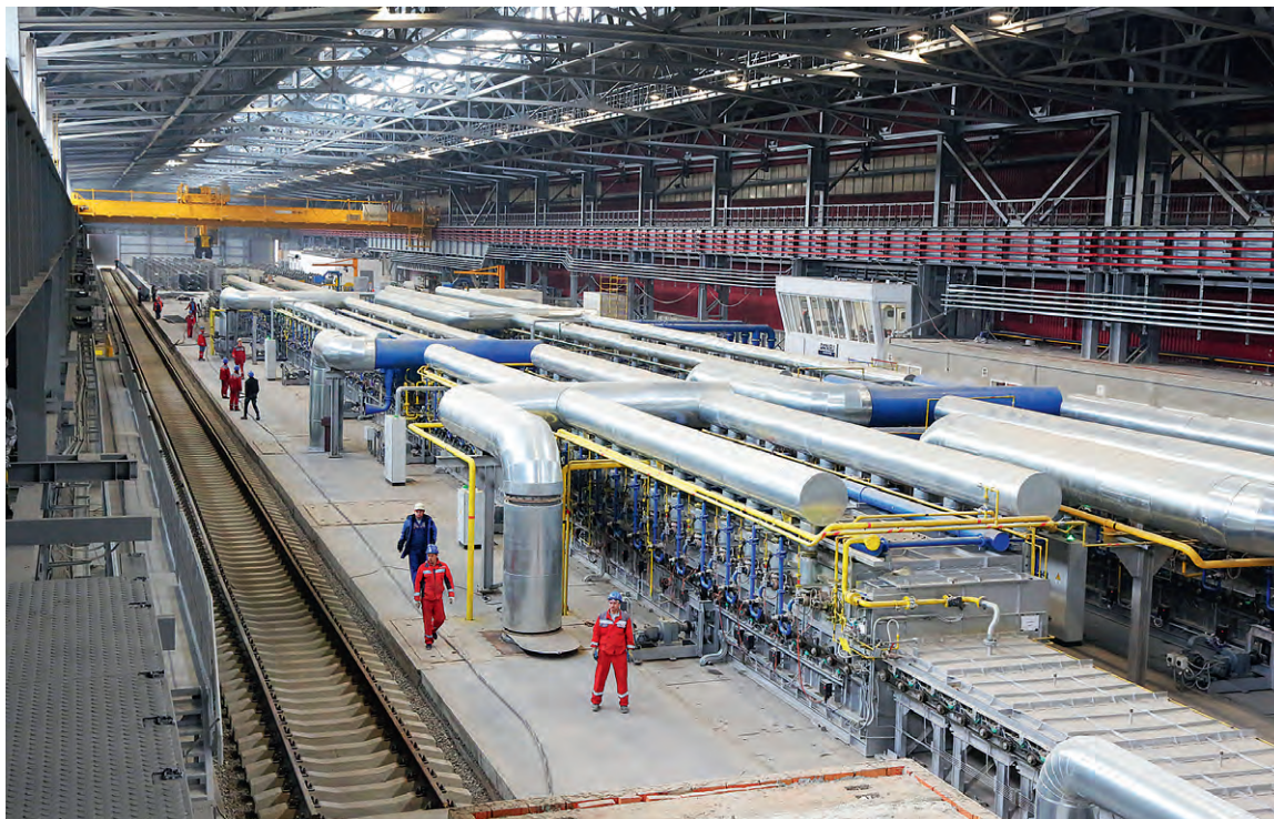
▲ На рабочей площадке ведётся комплексная наладка технологического оборудования
