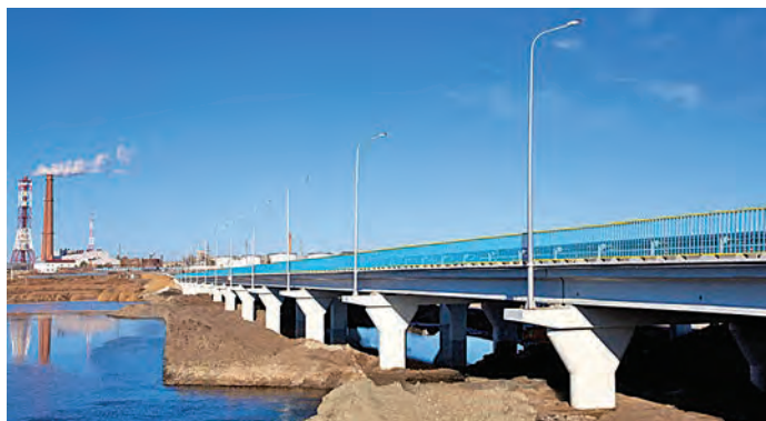
Строительство моста через реку Тобол.
