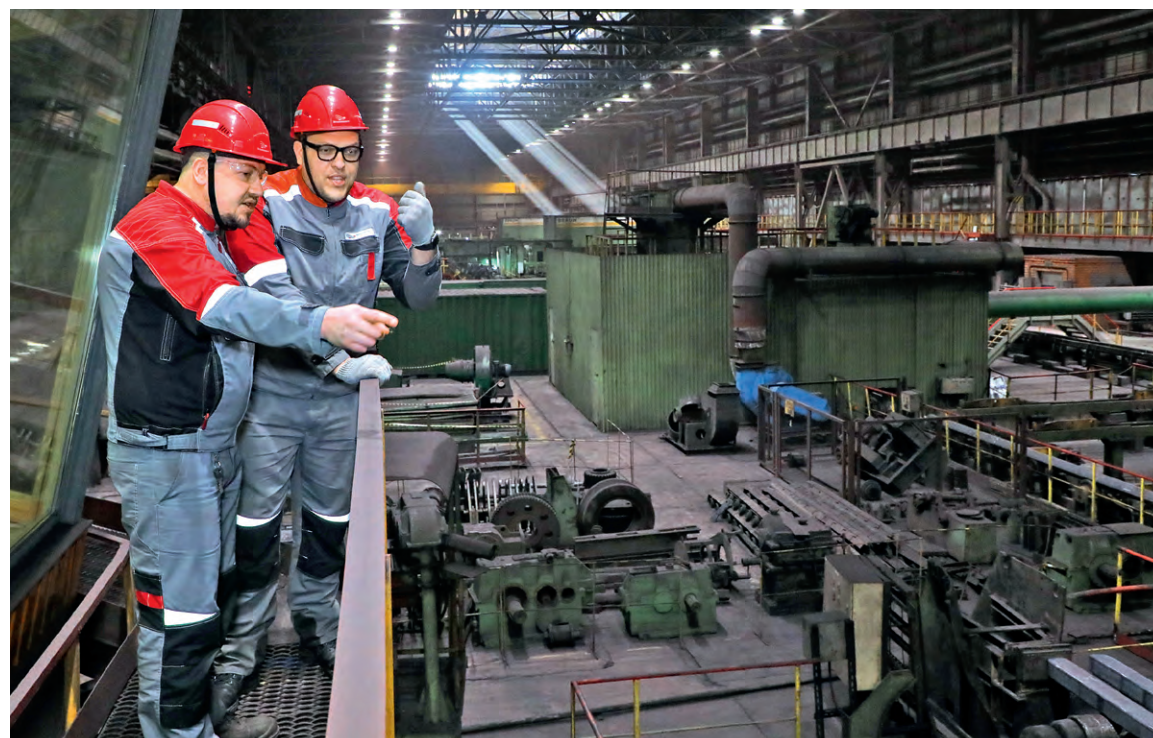
▲ Оператор поста управления Николай Кривчиков и бригадир Владимир Анучин ведут осмотр оборудования
