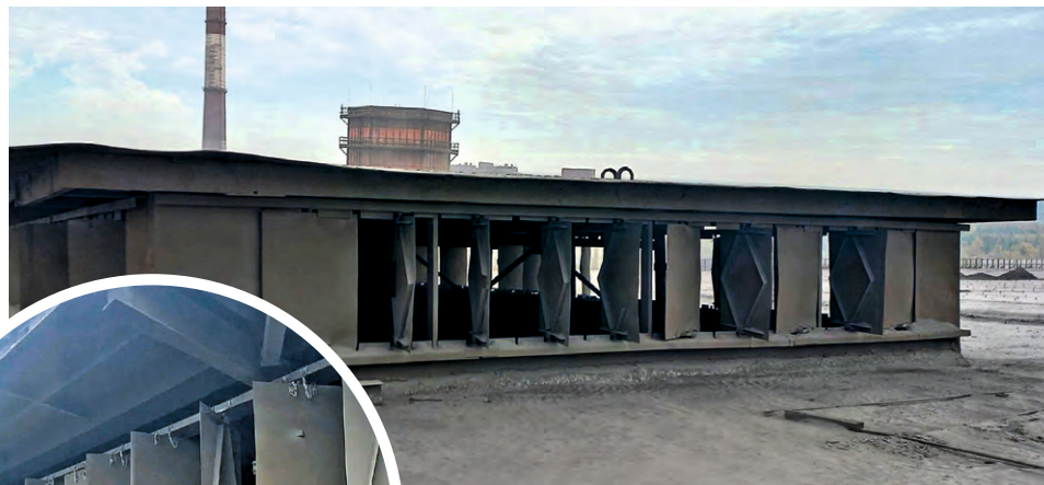
▲ Фрамуги дополнительно укрепили
