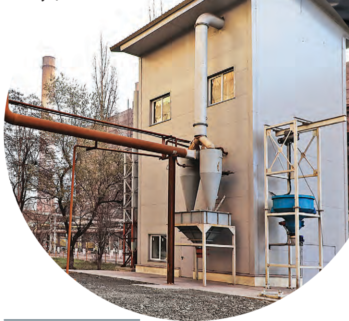
◀ Опытная установка сероочистки — это отдельно стоящее здание, куда из коллекторов обжиговой машины № 2 фабрики окомкования поступают отходящие газы
