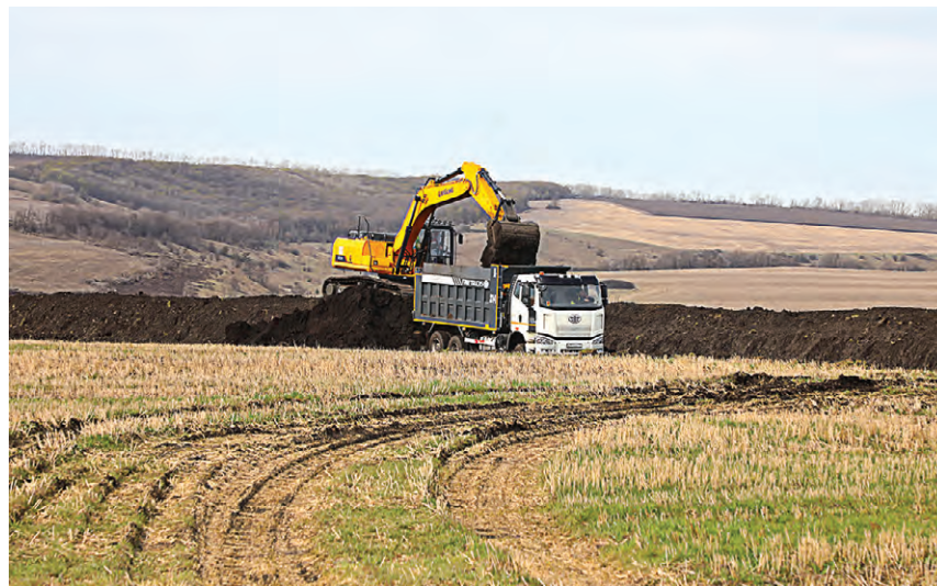
▲ Снятую при строительстве почву потом используют для рекультивации старого хвостохранилища
