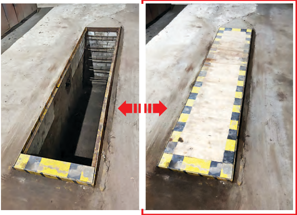
▲ Смотровая канава до установки защитного настила ▲ Такие защитные деревянные настилы будут применять во всех подразделениях МГОКа
