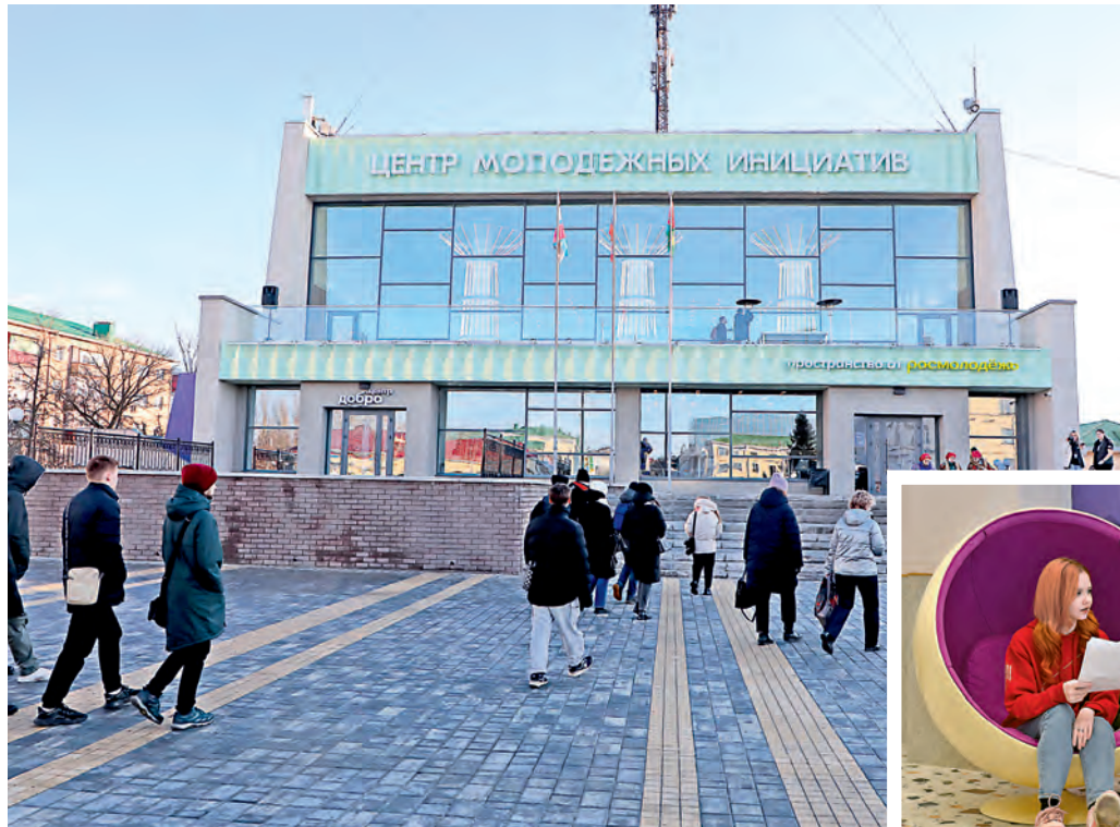
▲ Здание приобрело современный и стильный внешний вид
