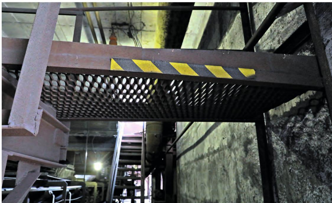
▲ Сигнальная лента на выступающих частях оборудования и металлоконструкций предохранит от опасности
