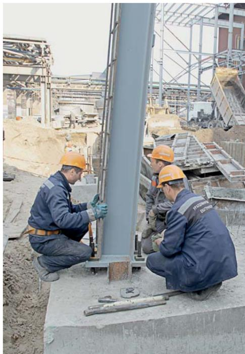
лита и выставление болтов под металлоконструкции. Впервые на комбинате монтаж металлоконструкций осуществляет выигравшая тендер тульская компания «Центрэнергосервис».
