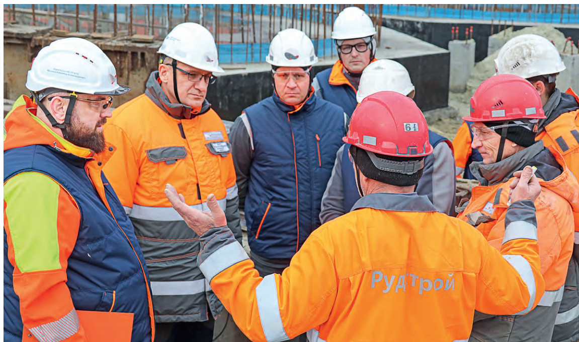
▲ Важный момент обхода — беседы с рабочими. Чаще всего они рассказывают о том, что нужно обновить средства защиты и инструменты. А ещё предлагают вносить дополнения в проекты производства работ, чтобы точнее выполнять строительные операции и не нарушать правила
