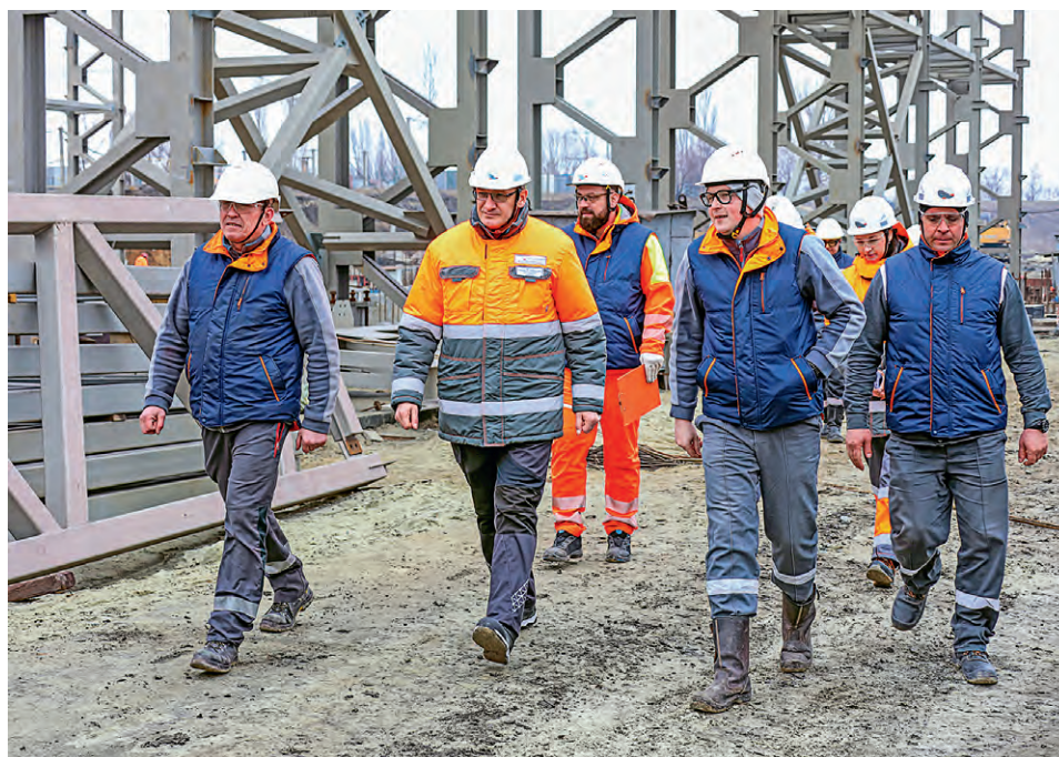
◀ Одна из групп Рудстроя посетила площадку строительства комплекса флотационного обогащения Лебединского ГОКа, где монтируют металлоконструкции корпуса
