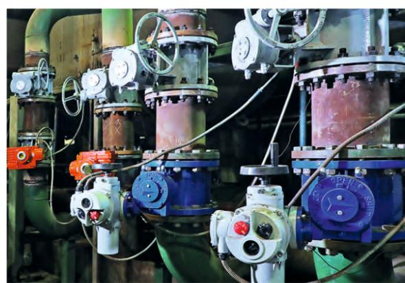
▲ На участке водоподготовки заменили 46 тонн металлоконструкций, более 400 задвижек и затворов
