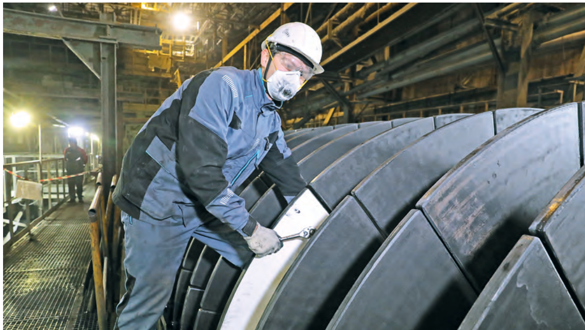
▲ Во время недавнего планового ремонта обжиговой машины в ФОиМ провели и техобслуживание керамических дисковых фильтров. Технический специалист подрядной организации Евгений Торонин выполняет замену фильтрующего элемента на КДФ-90
