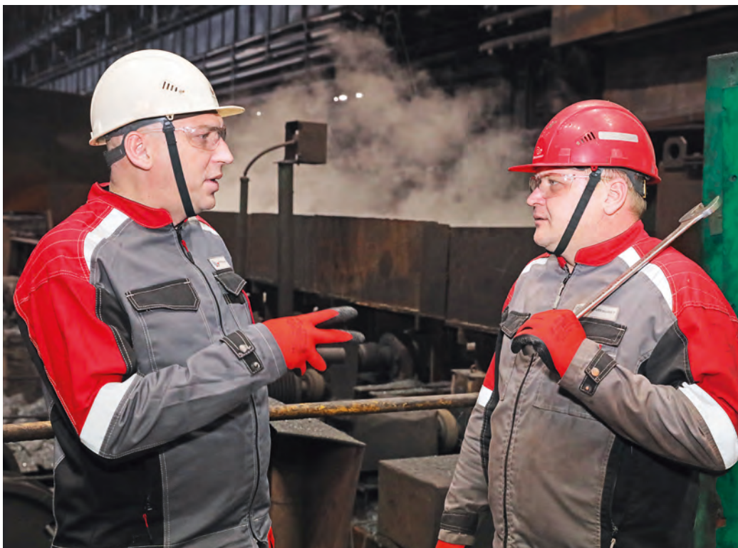
▲ Мастер участка водоснабжения и канализации СПЦ № 1 Юрий Полегаев и слесарь-ремонтник-сварщик Сергей Абакумов обсуждают детали монтажа рамки гидросбива окалины
