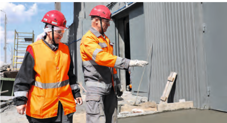
▲ Штукатурные работы в помещениях и обустройство бетонных площадок выполняют Елена Кулешова и её коллеги на важном объекте — третьей шлаковой яме ОЭМК
