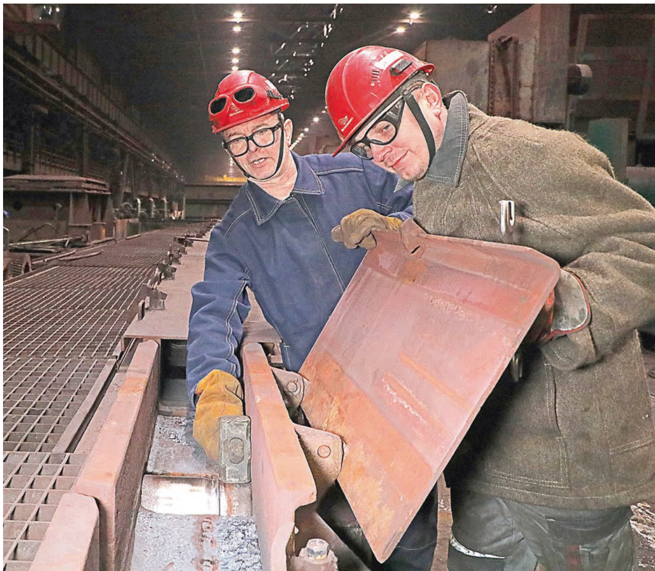
▲ Николай Капленко обучает молодого слесаря-ремонтника Валерия Студеникина основным операциям при демонтаже оборудования
