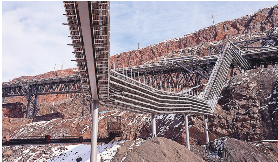
▲ Строители ДКК-2 применяли сложные и неординарные инженерные решения
